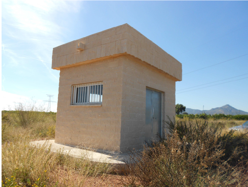
Figura 7. Aspecto exterior del pozo de Recarga Oeste (WRW)
