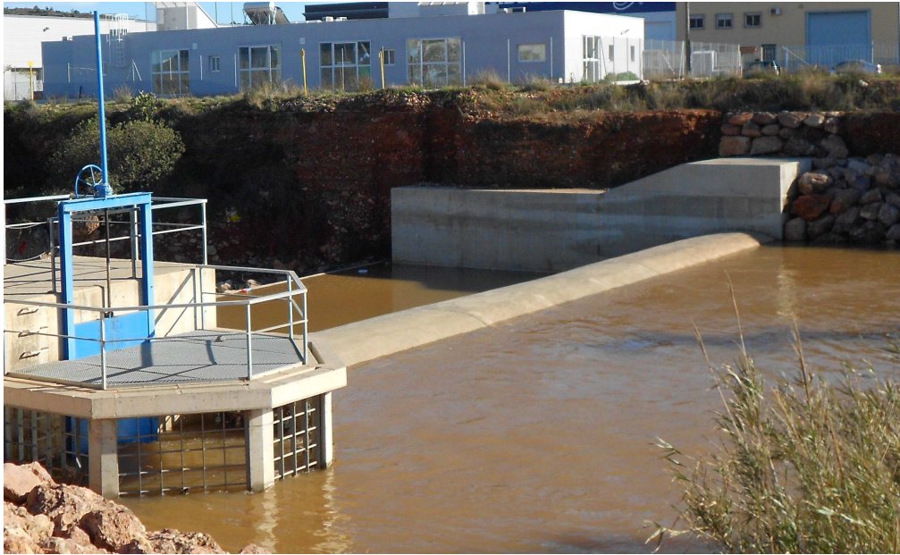
Figura 4. Azud de derivación en el cauce del río Belcaire
