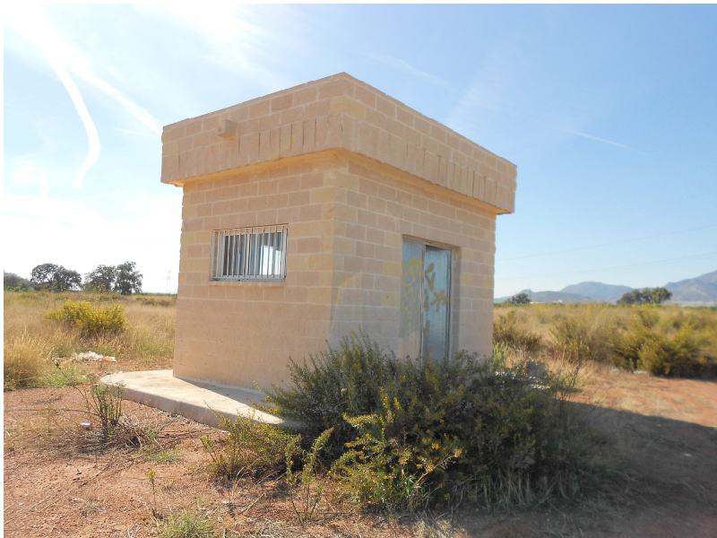
Figura 8. Aspecto exterior del pozo de Recarga Este (ERW)
