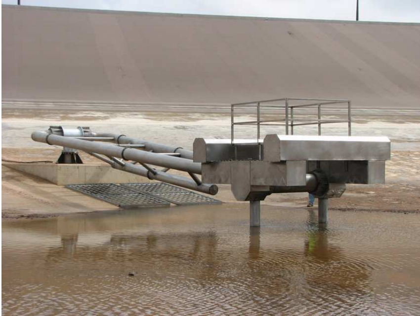
Figura 6. Salida inferior y dispositivo de la toma flotante de la balsa
